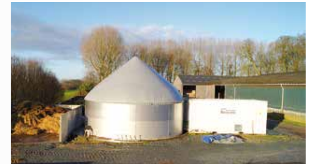
Unité de biométhanisation par cuve verticale, avec stockage du biogaz par bâche sur la cuve et conteneur équipé (dont le système de cogénération).
